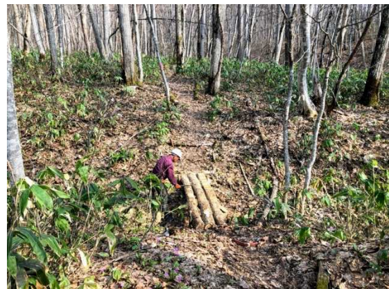
谷渡りルート橋更新
