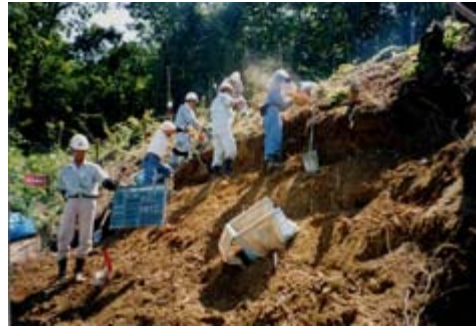
② 改変部からの土壌の切出し
