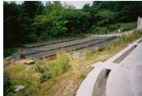
⑥ 移植先での養生状況
