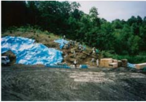
① トンネル坑口部での掘り取り作業
