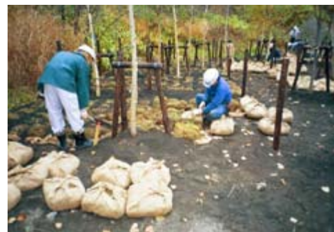
⑧ トンネル坑口部における再移植作業中
